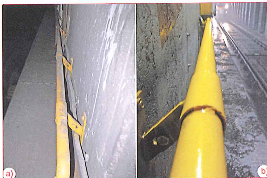
Fig. 3 - Un particolare del tunnel a) prima dell'intervento b) dopo l'intervento
