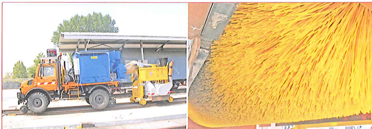
Fig. 8 - Il mezzo Tecnofer SAI 150, sulla destra il particolare della spazzola rotante
