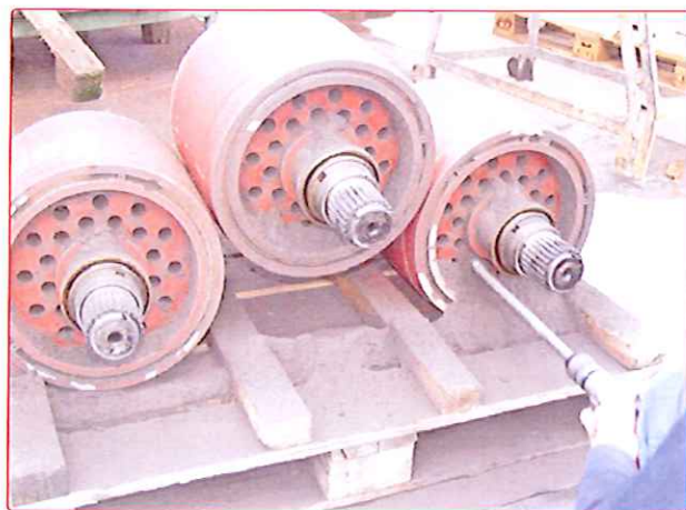
Fig. 5 - Rimozione delle polveri da elementi di motori di elettotreni
