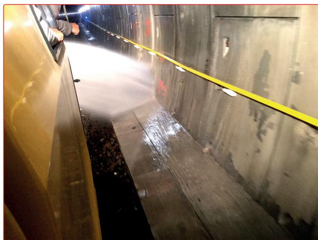
Fig. 6 - "Salt 700" in fase di "scopatura idrica" del camminamento di servizio
