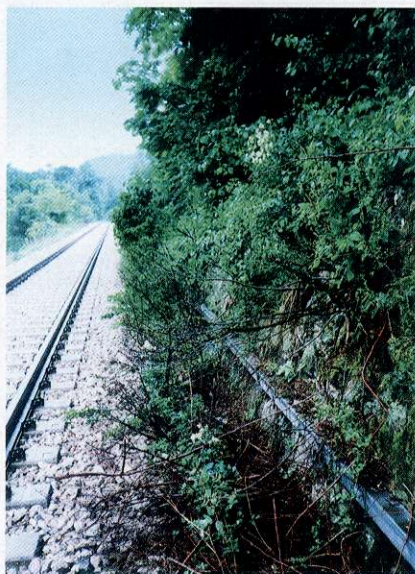
Fig. 1 - Rigogliosa vegetazione spontanea insediata su un muro di sostegno a secco (Linea Bassano-Primolano)
