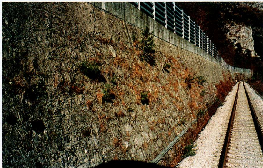
Fig. 2 - Anche su un muro in mattoni, nonostante il cemento sigilli gli interstizi, è possibile l'insediamento di pericolose piante arboree, come questo piccolo abete al centro dell'immagine
