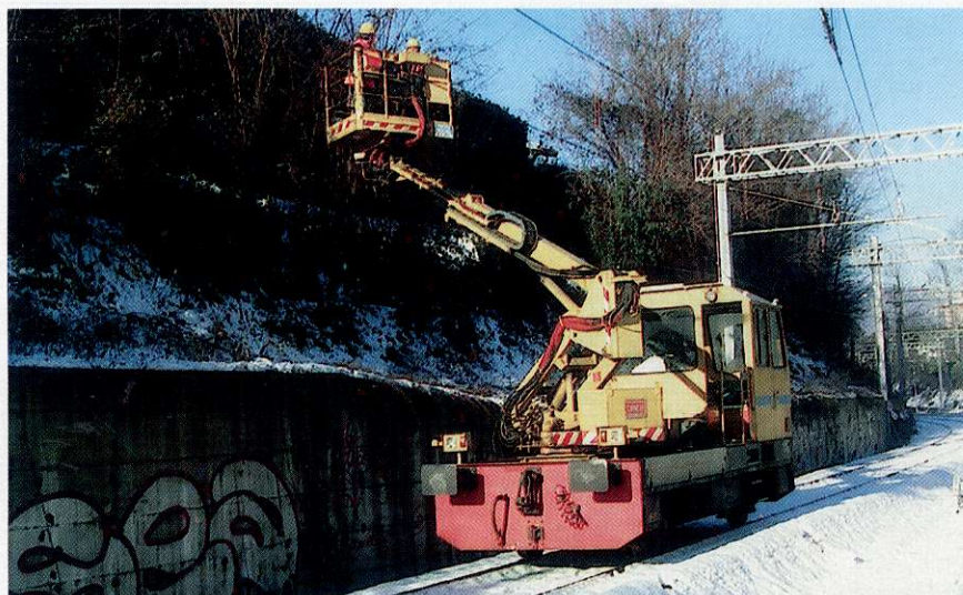
Fig. 5 - Carrello con autoscala per l'intervento meccanico manuale
