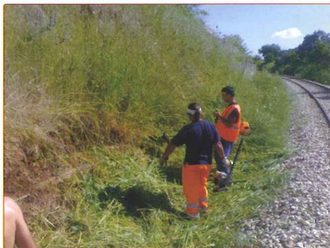
Fig. 2 - Sfalcio di una canaletta in zona non diserbata
