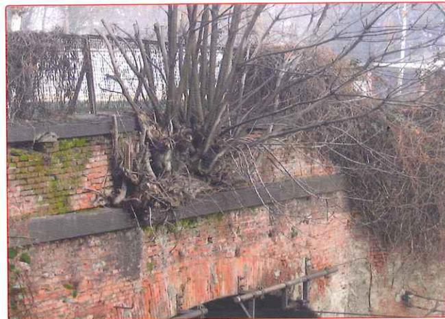
Fig. 18 - Effetto delle radici di una pianta sulla struttura di un portale
