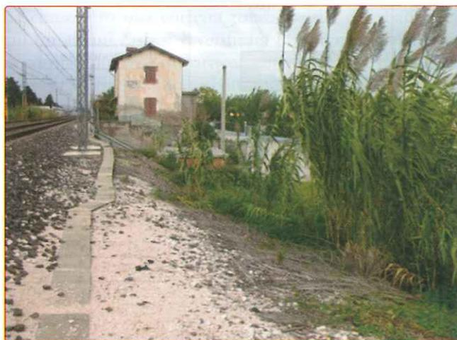
Fig. 3 - Il diserbo facilita gli interventi manutentivi lungo i binari (visita linea, interventi agli impianti elettrici in canaletta, percorribilità dei sentieri in caso di particolari eventi, ecc.)
